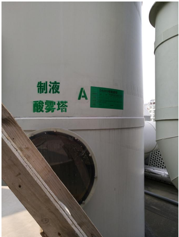
溶铜废气吸收塔
