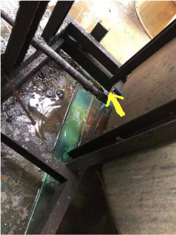
喷淋塔整改前（排水管脱落）
