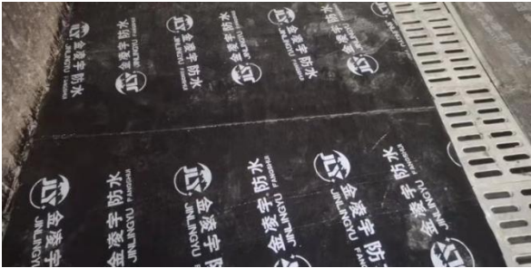
危废间整改后（加 SBS 防水防腐卷材）
