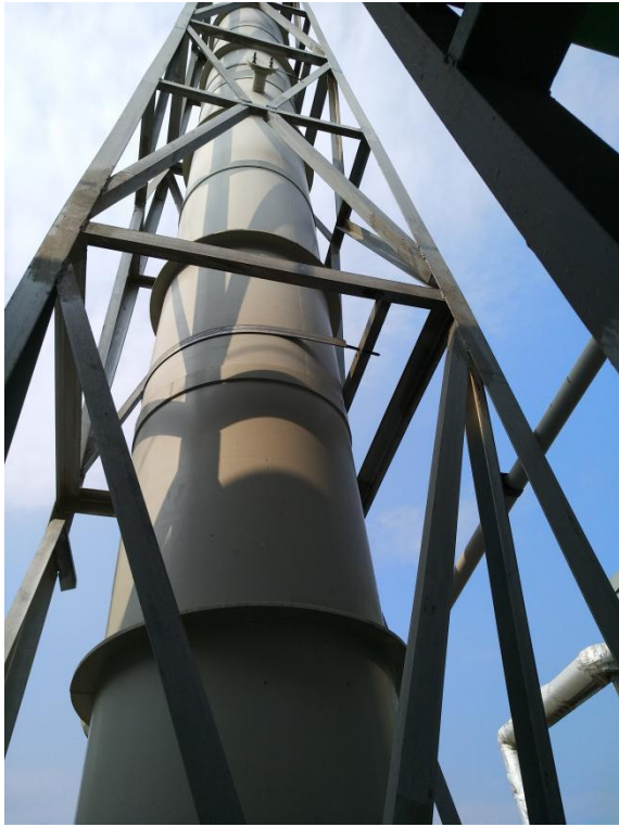
溶铜废气排气筒
