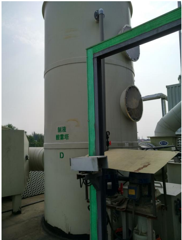
溶铜废气吸收塔
